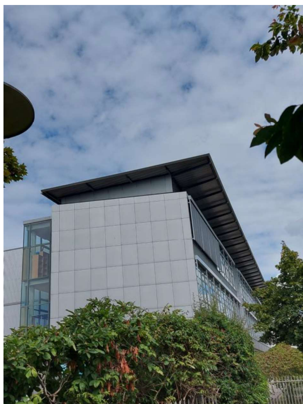
Abbildung 3 Westseite des Bestandsgebäudes
